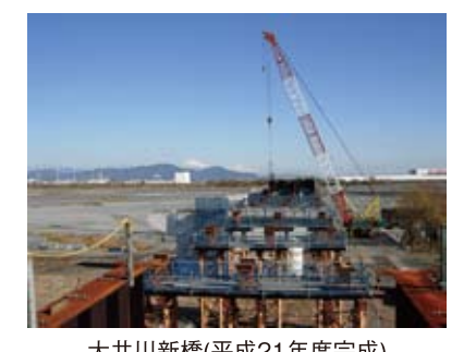
大井川新橋(平成21年度完成)
