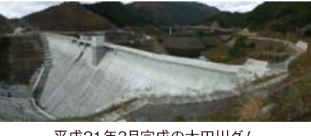
平成21年3月完成の太田川ダム
