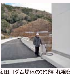
太田川ダム堤体のひび割れ視察
