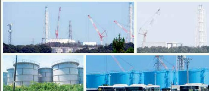
毎日400 t 放射能汚染水貯留する全タンクは約930基、灰色がボルト締め型約300基。漏えいが発生。青色は鋼製で容量1,000 t。しかし、300 tは海へ
