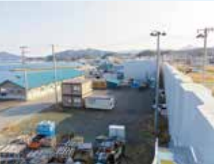
山田町は静岡県土木支援3人で防潮堤工事も進む
